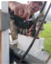
Reconexión de cables
