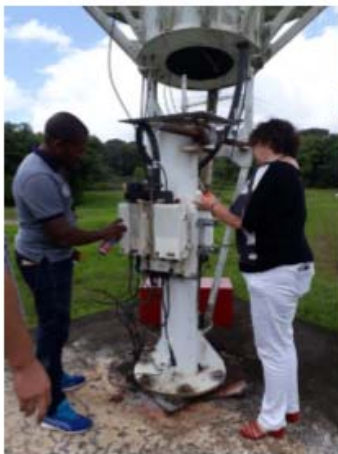
Limpieza componentes antenna
