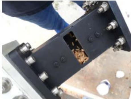
Mantenimiento componentes interior antenna (outdoor) – presencia de insectos
